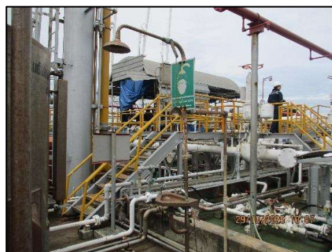
ภาพถ่ายที่ 2.2-20 การติดตั้งอุปกรณ์ป้องกันระงับเหตุอัคคีภัยและอุปกรณ์บรรเทาภัย ภายในบริเวณพื้นที่ทำเทียบเรือ
