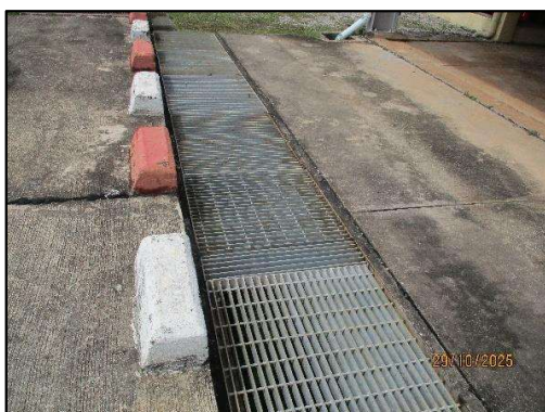
ภาพถ่ายที่ 2.2-7 รางระบายน้ำภายในพื้นที่โครงการ
